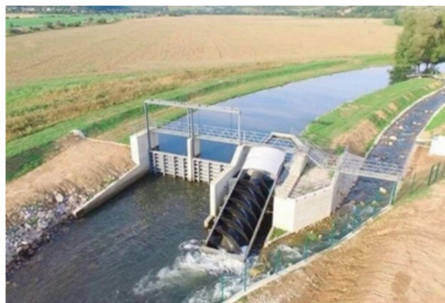
Рисунок 10 -Гидроэнергетический винт
