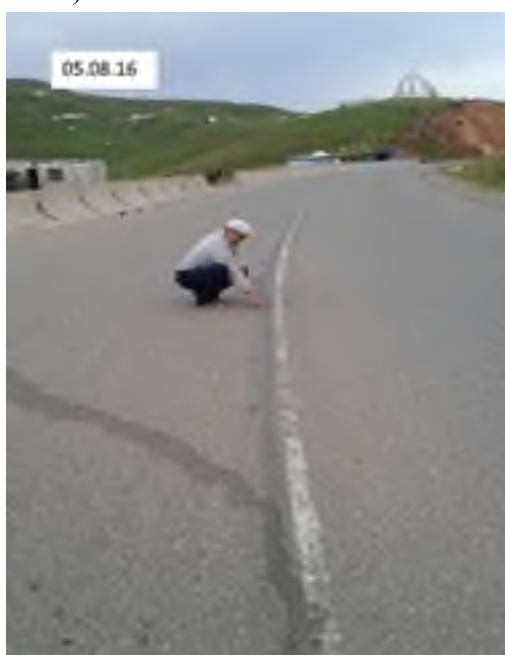
Рис. 1. Влияния деформации пользучести на состояния автомобильной дороги Ош-Сарыташ-Иркештам на перевале «Чыйырчык».
