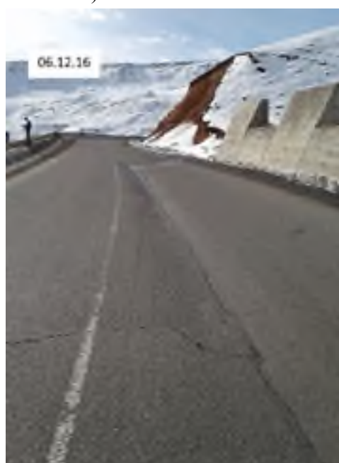
Рис. 1. Влияния деформации пользучести на состояния автомобильной дороги Ош-Сарыташ-Иркештам на перевале «Чыйырчык».
