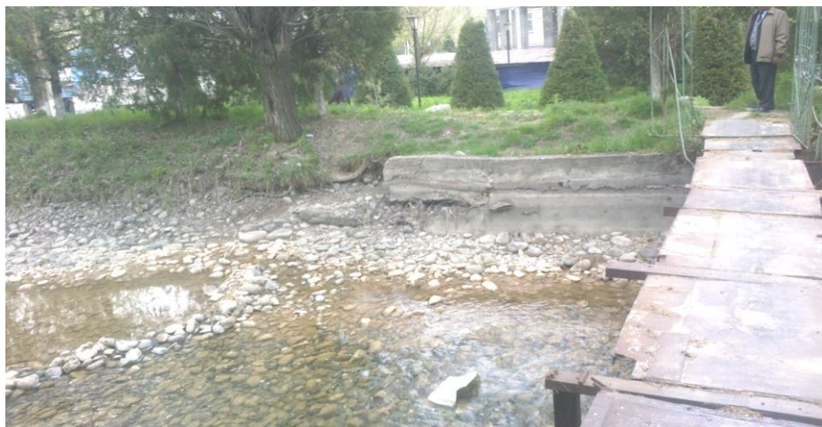
Рисунок 2 -Укрепление дна реки у берегозащитного сооружения на р. Талдык-Суу
