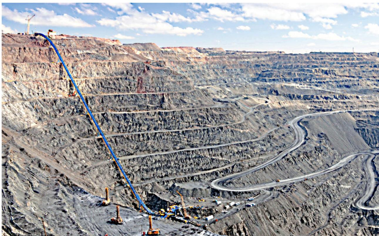
Рисунок 5 – Общий вид карьера «Мурунтау» с крутонаклонным конвейером
